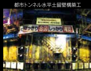
都市トンネル水平土留壁構築工
