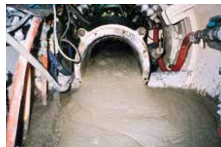
排泥状況(砂層)
