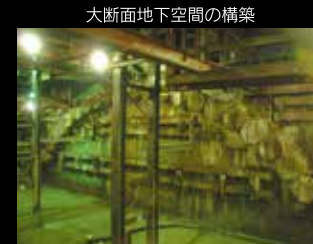
大断面地下空間の構築
