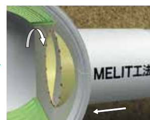
④切削リングをカッタスポークを介して回転させて、既設管渠を直接切削
