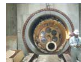
掘進機駆動部引戻し状況
