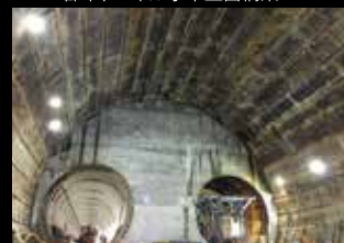
都市トンネル水平土留構築工
