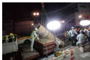
掘進機回収状況①
