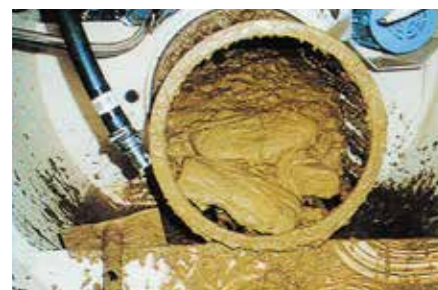
排泥状況(玉石層)
