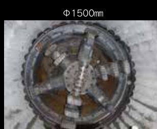
既設暗渠直接切削到達完了
