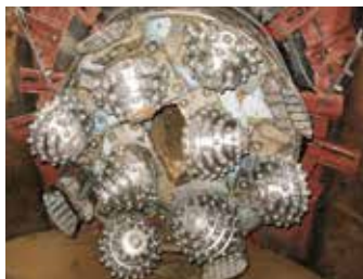
掘進機到達状況
