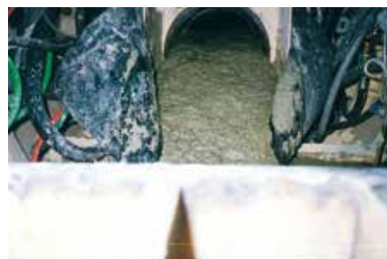
排泥状況(砂礫層)
