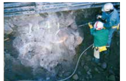
①発進立坑土質状況 岩盤人力掘削状況: Max2000mm以上
