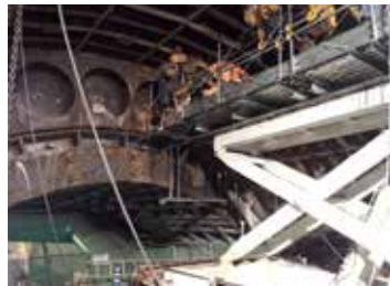
施工状況(ユニバーサル架台使用)
