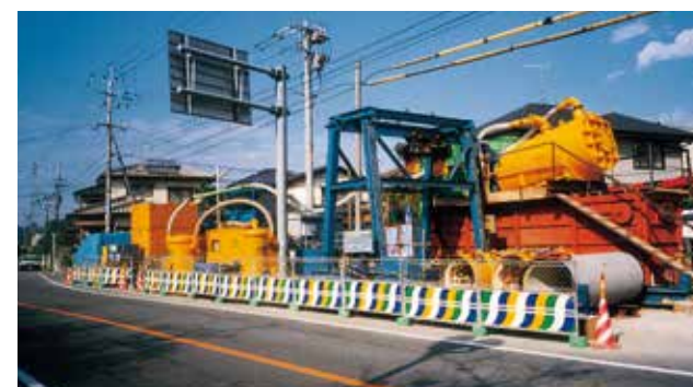
推進設備全景(産業廃棄物処理方式)
