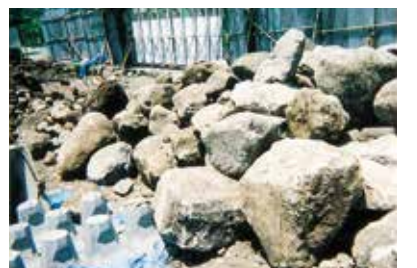
②立坑掘削時の掘出玉石 カームマイト等使用(小割り)
