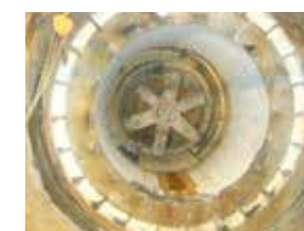
掘進機駆動部引戻し状況
