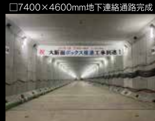
□7400×4600mm地下連絡通路完成
